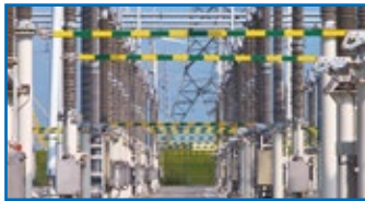
Medición líneas eléctricas
